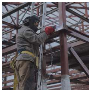
Строительство, монтаж металлоконструкции
